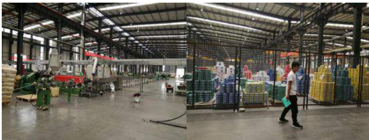
项目废气收集管道
